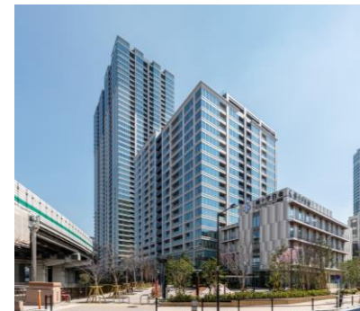
▲ SHIROKANE The SKY (白金一丁目東部北地区第一種市街地再開発事業)
