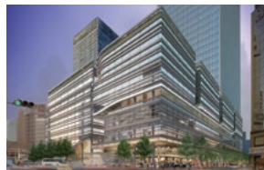
八重洲通り・八重洲仲通り側
