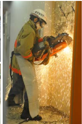
壁を破壊しての救助訓練
