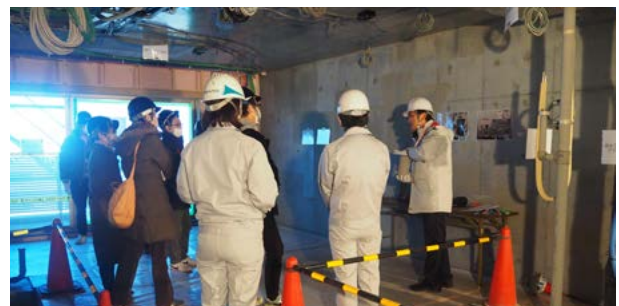
躯体・コンクリート面の現場見学
