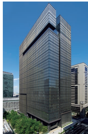
大手町の森と大手町タワー
