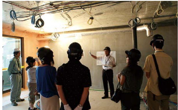
躯体・コンクリート面の現場見学会の様子
