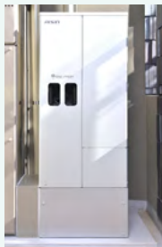
住戸に設置されたエネファーム
