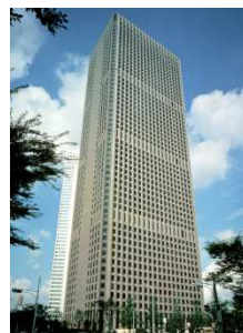
新宿センタービル
