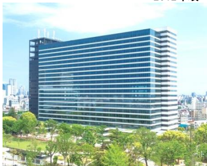
中野セントラルパーク(サウス) ◆◆ 2012年竣工
