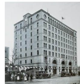
竣工当時の本社ビル
