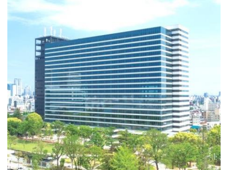
中野セントラルパーク(サウス) ◆◆ 2012年竣工
