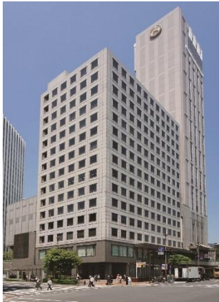
横浜ファーストビル 1998年竣工
