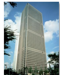
新宿センタービル
