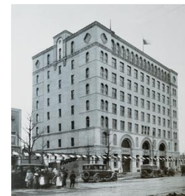
竣工当時の本社ビル
