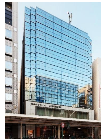
四条SETビル(1992年竣工)
