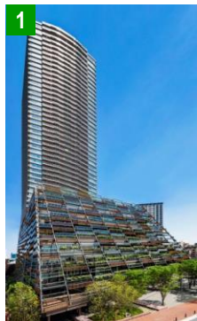
1 Brillia Tower 池袋 (2015年竣工)
