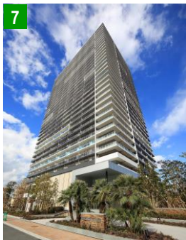
7 Brillia 有明 City Tower (2015年竣工)
