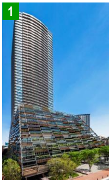
1 Brillia Tower 池袋 (2015年竣工)
