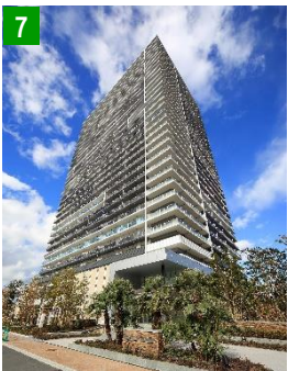
7 Brillia 有明 City Tower (2015年竣工)
