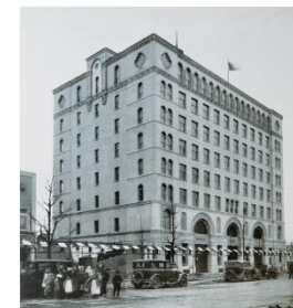
竣工当時の本社ビル
