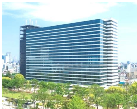
中野セントラルパーク サウス (2012年竣工) ◆◆
