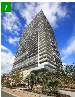
7 Brillia 有明 City Tower (2015年竣工)
