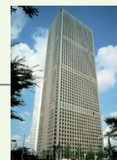
新宿センタービル
