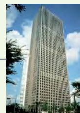
新宿センタービル
