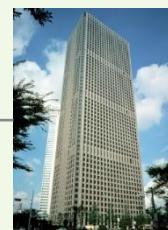
新宿センタービル
