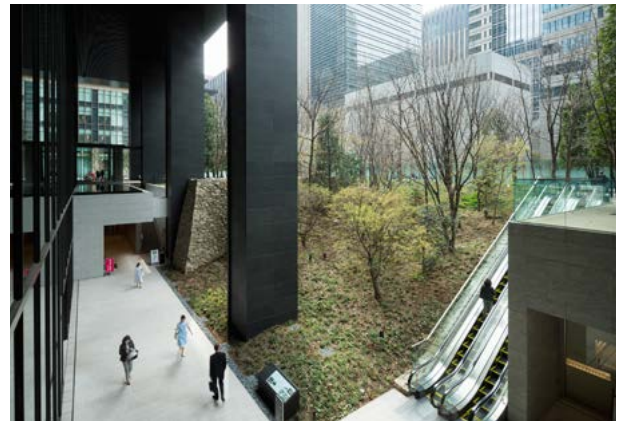
地下1階から外に出ると「大手町の森」につながっている。森を介して地上と地下の歩行者動線が結ばれる
