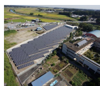
小山太陽光発電所
