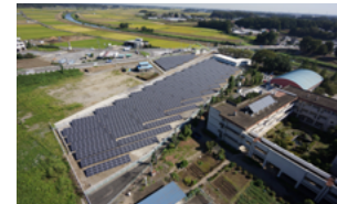
小山太陽光発電所
