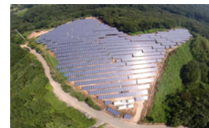
鳩山太陽光発電所
