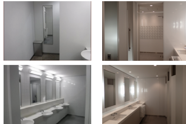
四条烏丸FTスクエアのトイレリニューアル工事 左:改修前 右:改修後
